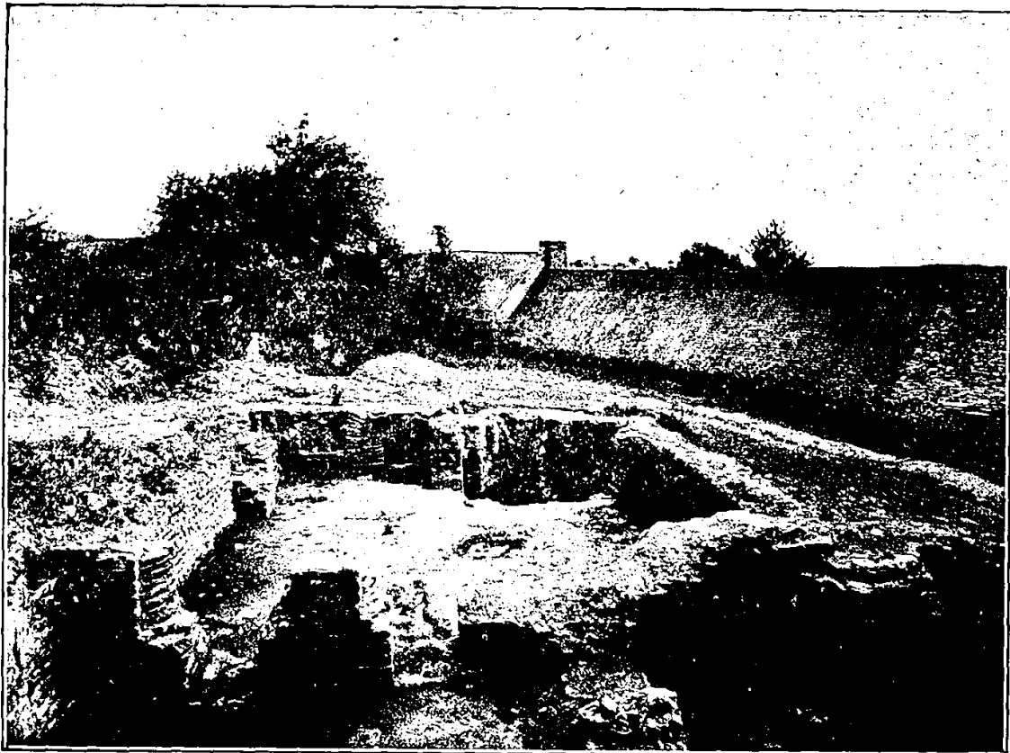
BAINS CHAUDS AVEC SALLE DE SERVICE
